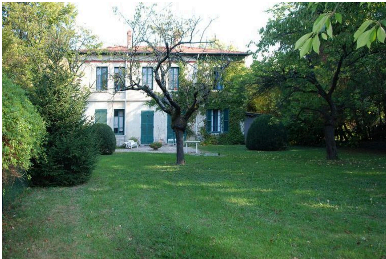
Bâtiment 225, vue d'ensemble depuis le sud
