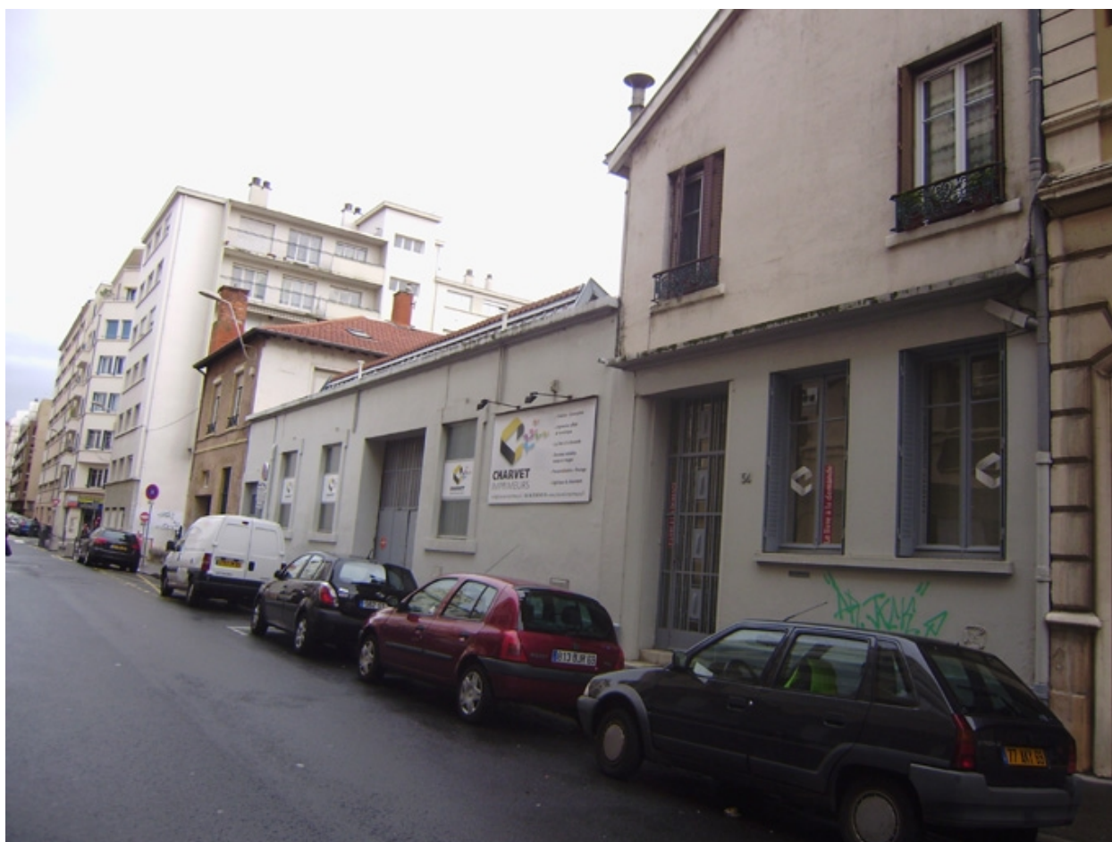
Vue d'ensemble ouest
