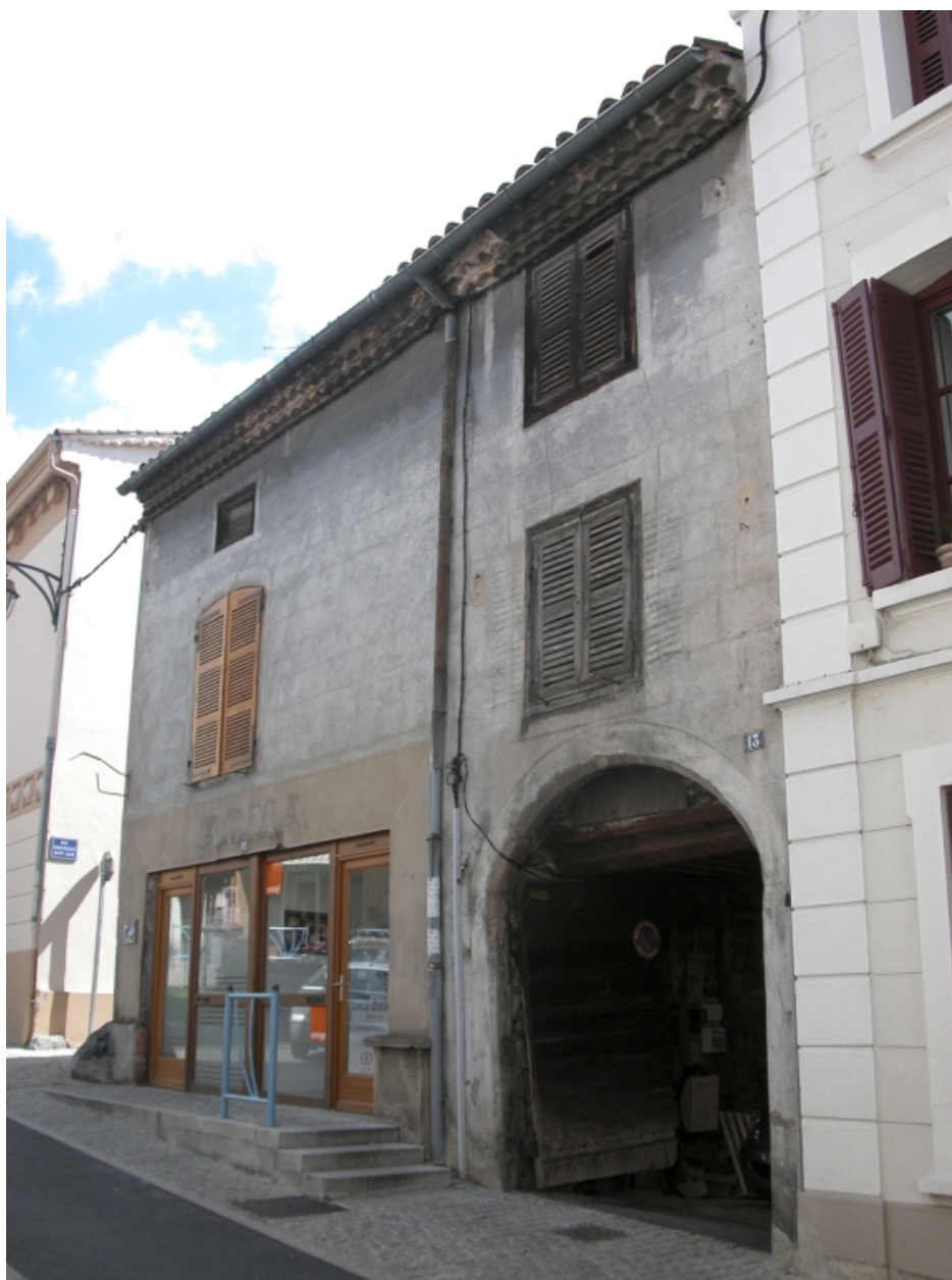
Îlot 2. Roanne (rue de) 13, 15. Vue d'ensemble de la travée au-dessus du passage couvert.
