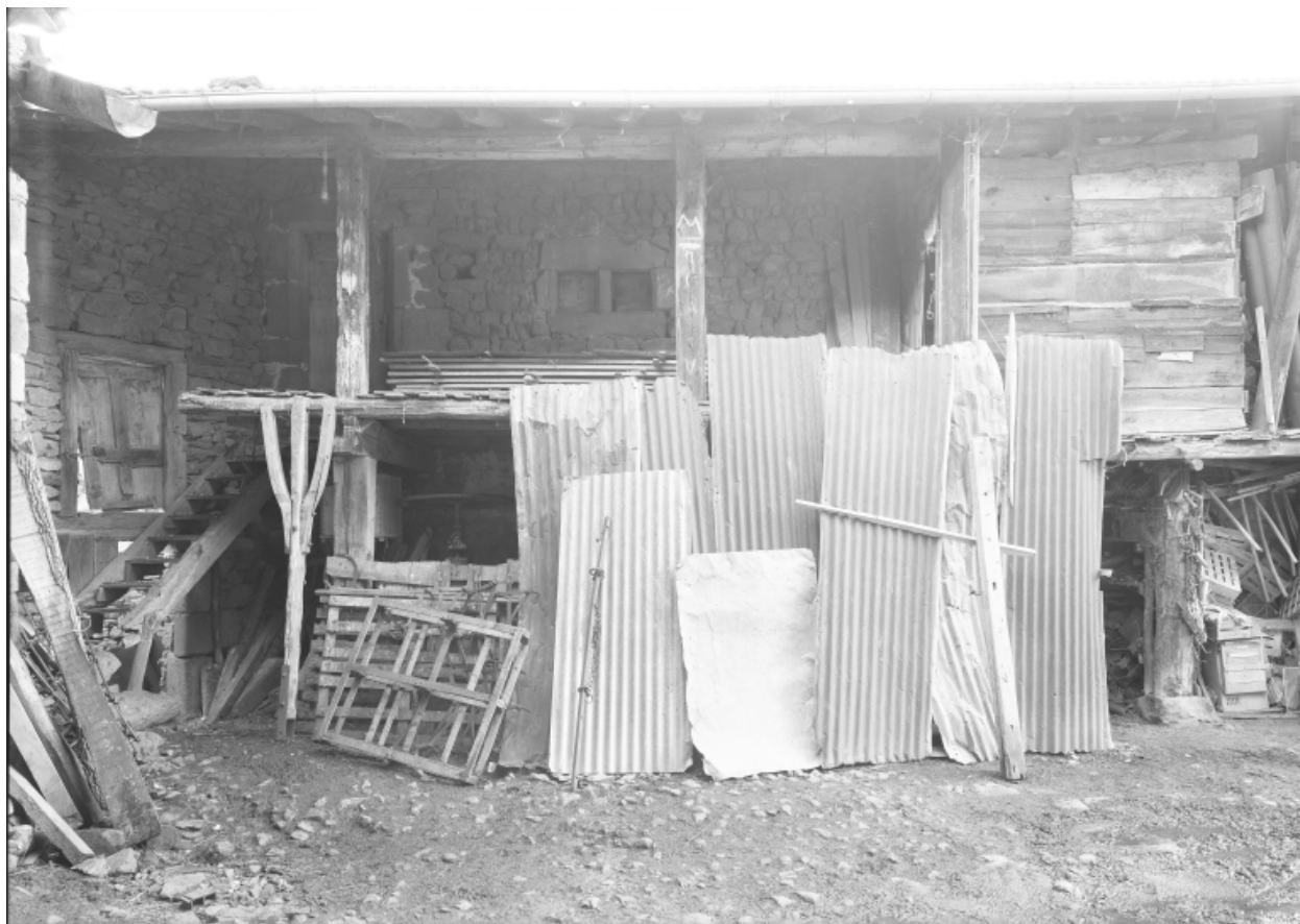
Vue d'ensemble de face de la ferme.
