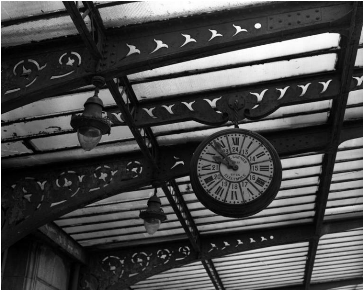
Gare de Châtel-Guyon, détail de la marquise avec horloge. En 1978.
