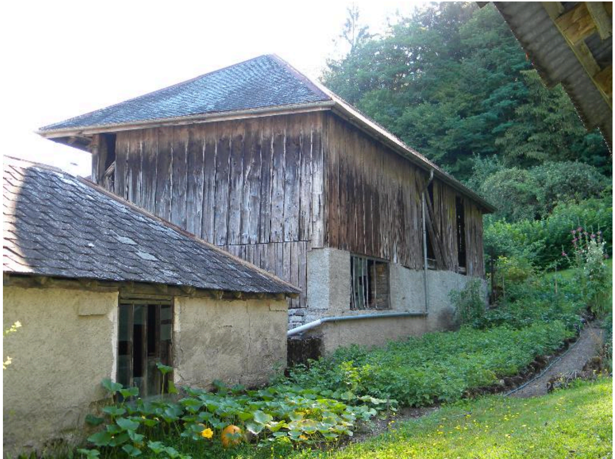
Vue de la façade arrière d'un établissement hydraulique (2008 D4 803)
