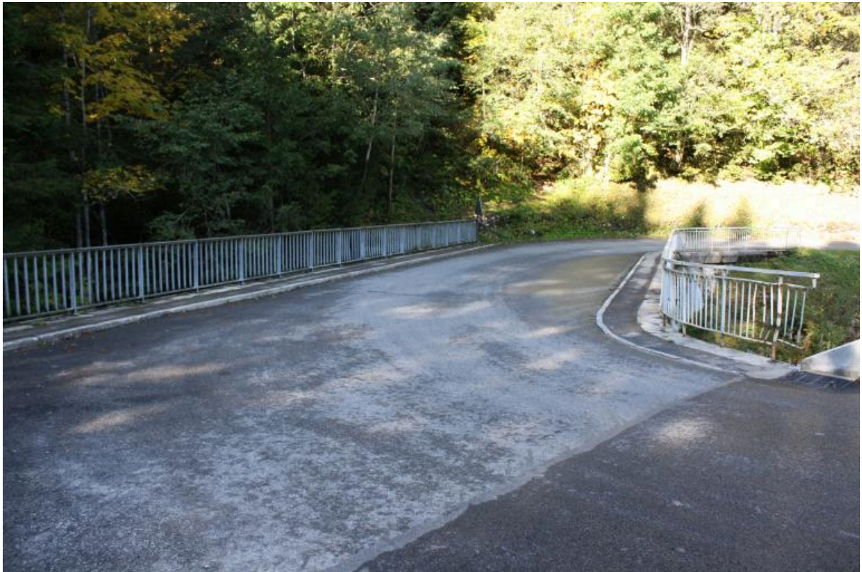
pont de Dinn, vue chaussée et garde corps
