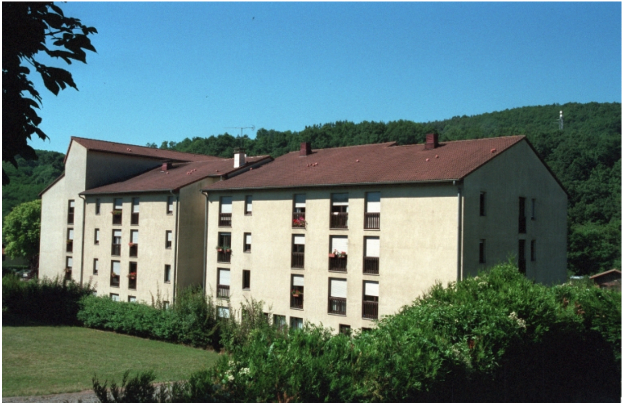
Boën, îlot 13, J-B David (rue), cad. AL 838, 841. Vue générale des immeubles.
