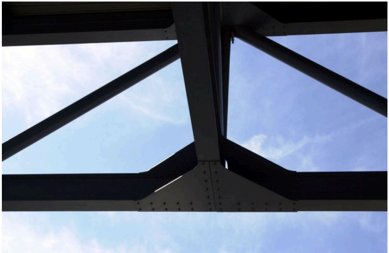
Assemblage des poutres par boulonnage
