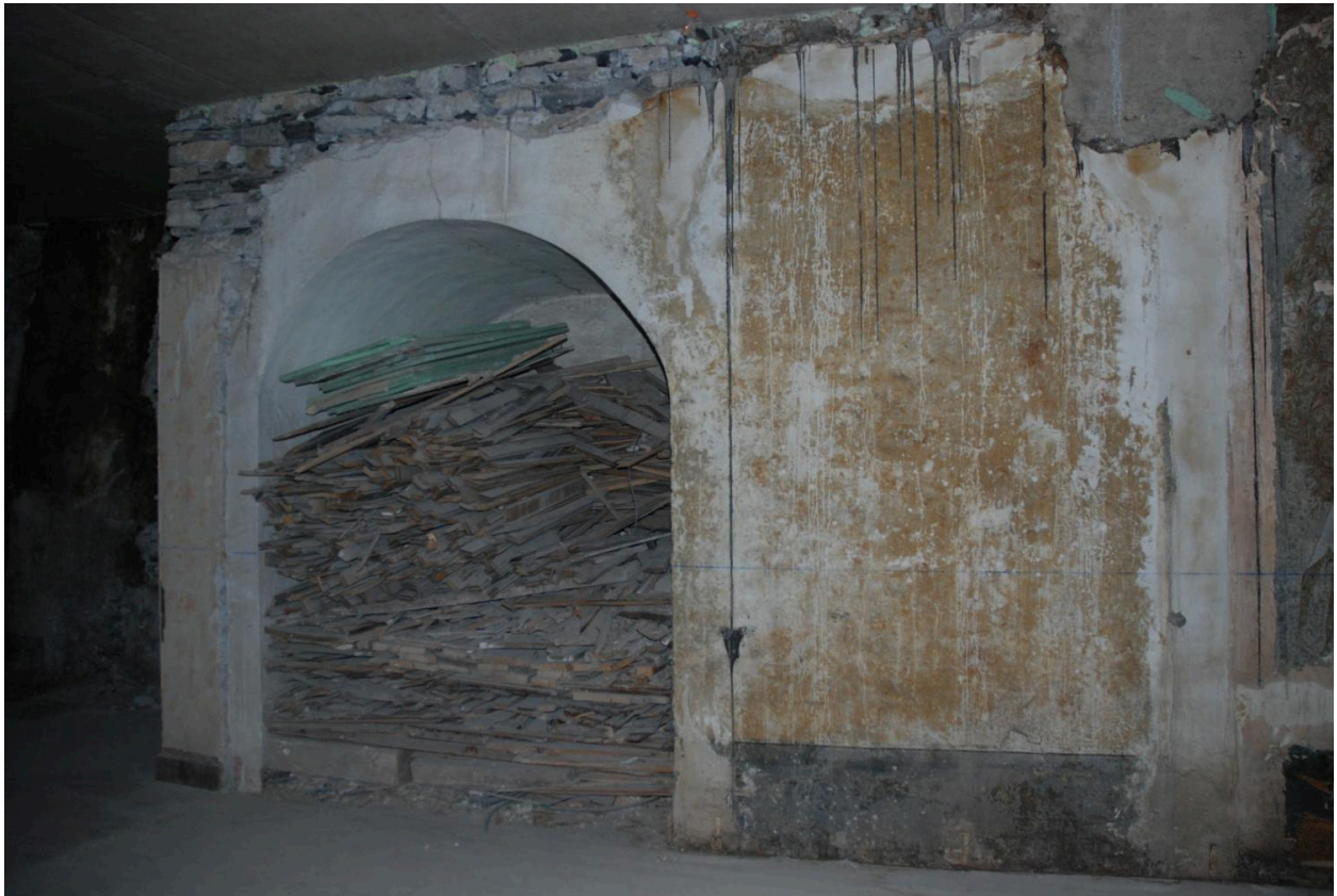
Vue intérieure du 1er étage : niche dans le mur ouest.
