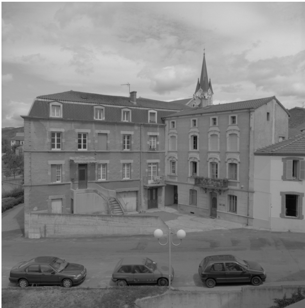
Vue des façades sur cour des maisons situées aux 5-7-9 rue de la Gare, du sud.
