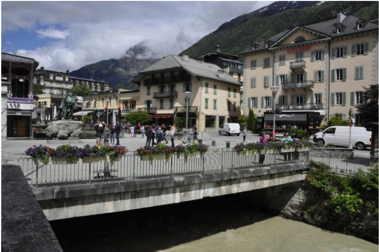
Vue de la face aval du pont
