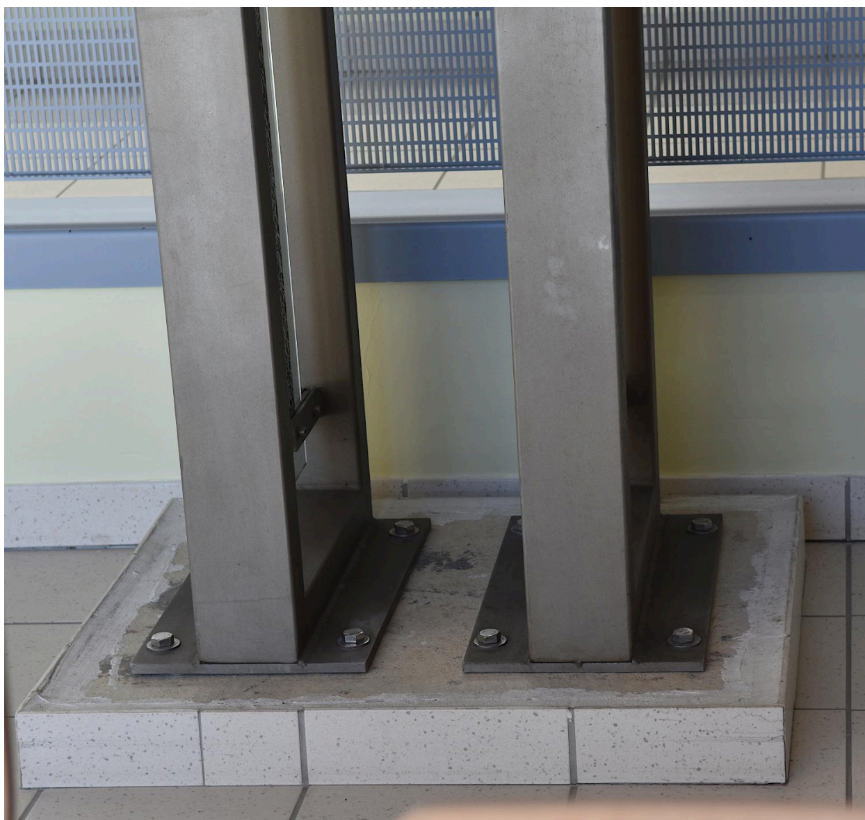
Installation n°5 : détail des platines d'ancrage au sol
