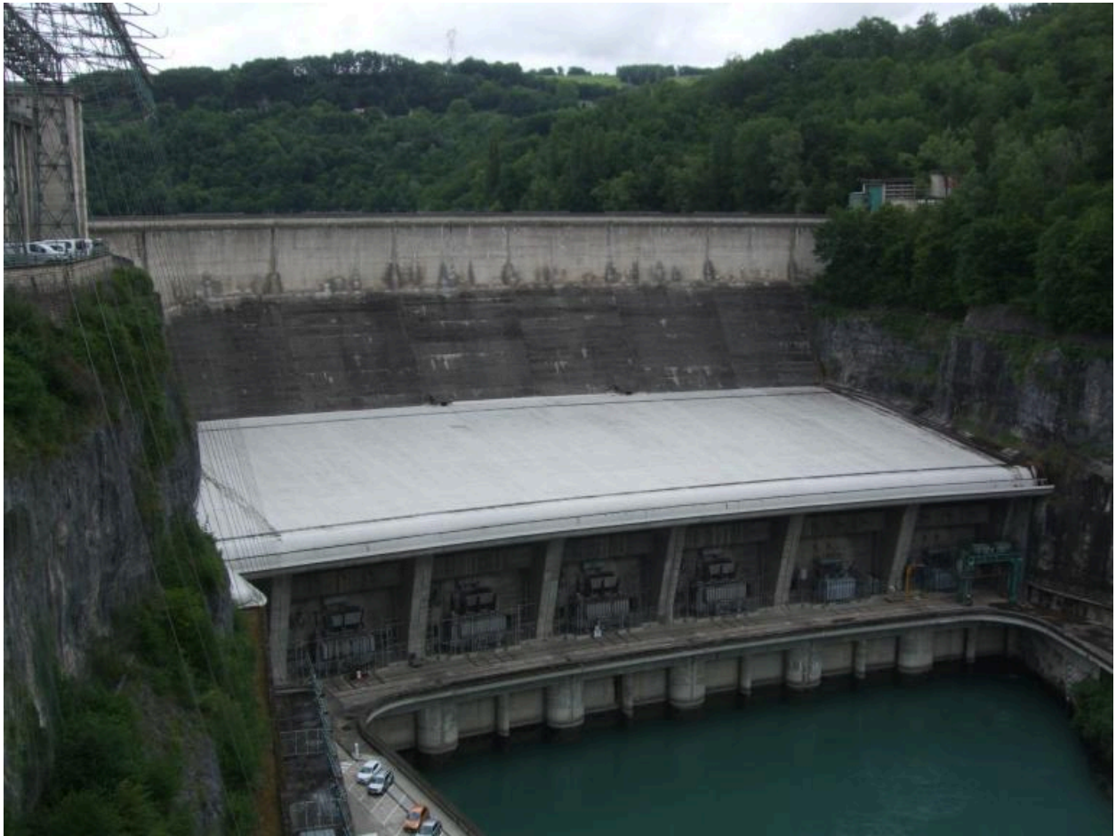
Toit de la centrale et vue aval des 6 transformateurs.
