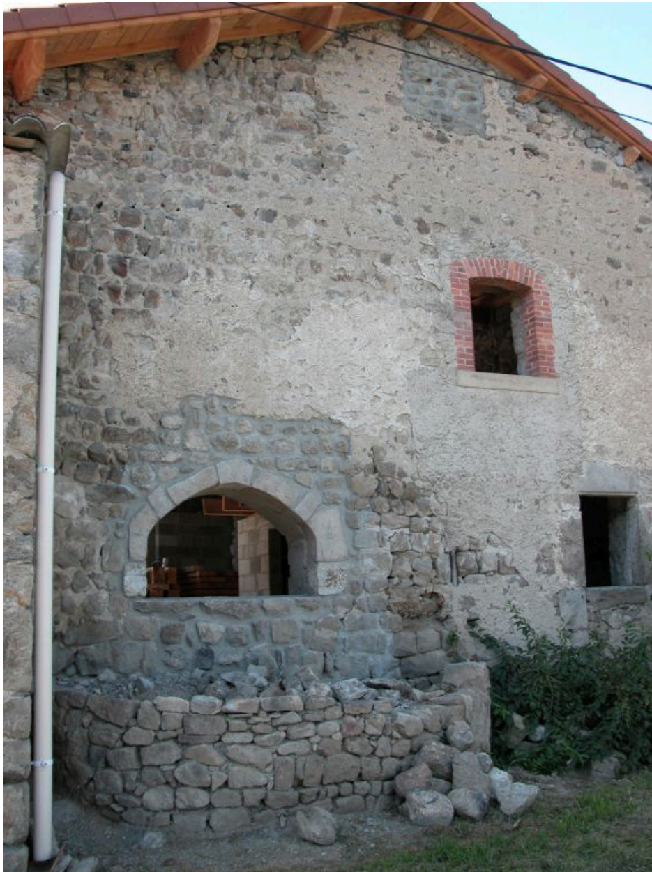
Vue du mur pignon du logis 4, depuis l'est : emplacement de la voûte du four à pain (état en 2011).
