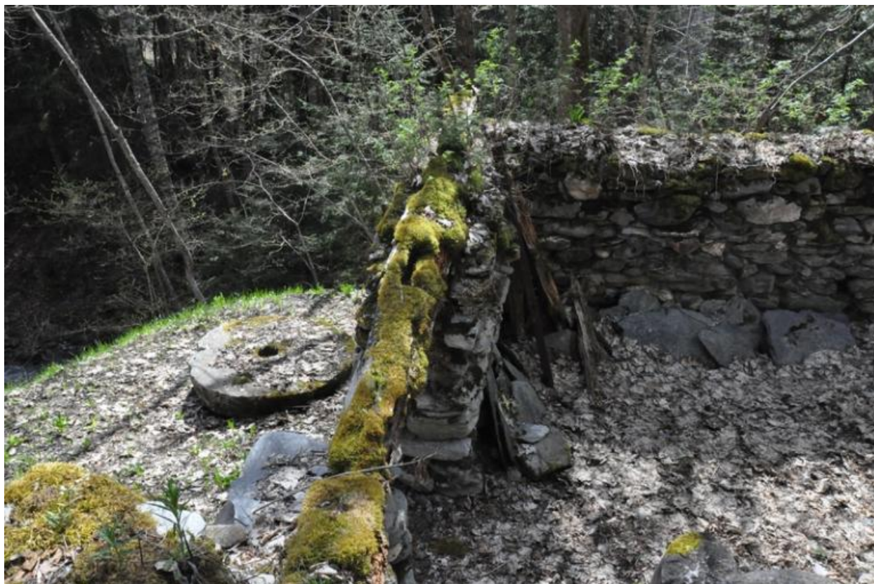
Vestiges du moulin aval.
