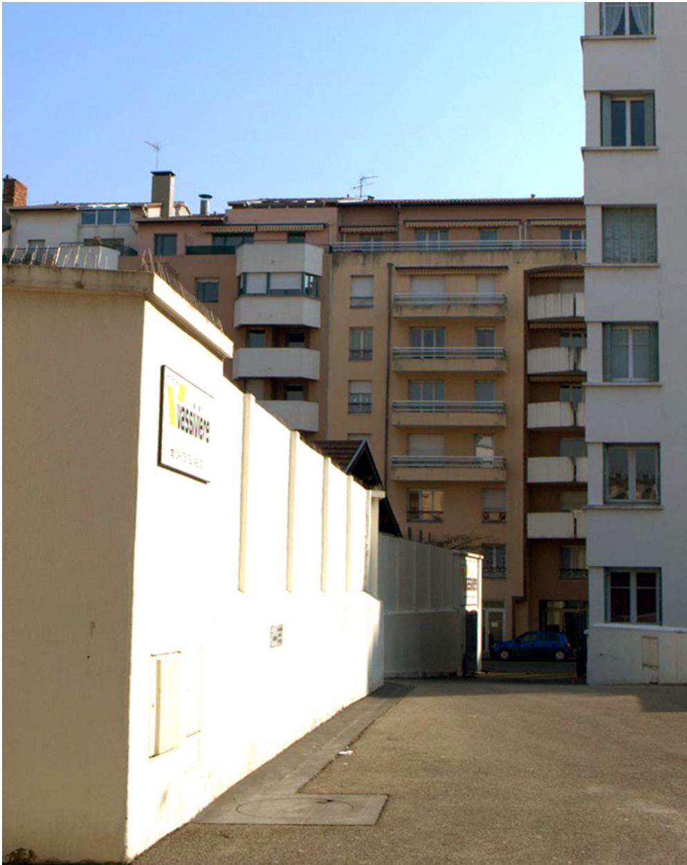
Elévation antérieure, vue partielle depuis la cour du 8 rue Nicolai
