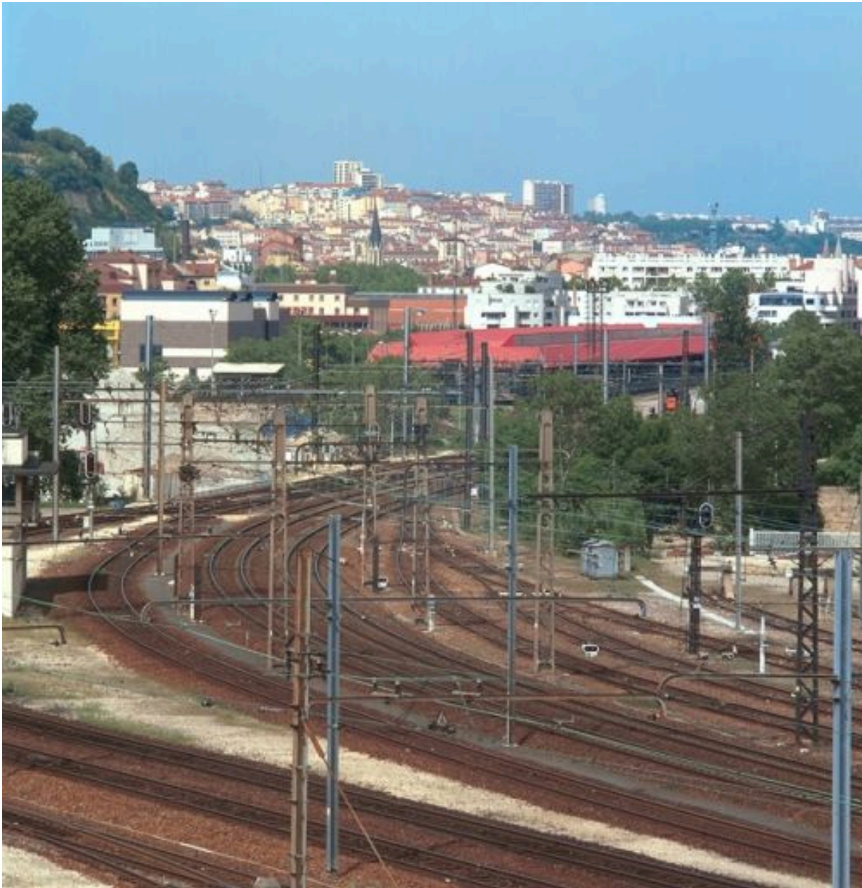
Vue d'ensemble du réseau ferré sud, depuis le toit de l'entrepôt des sucres
