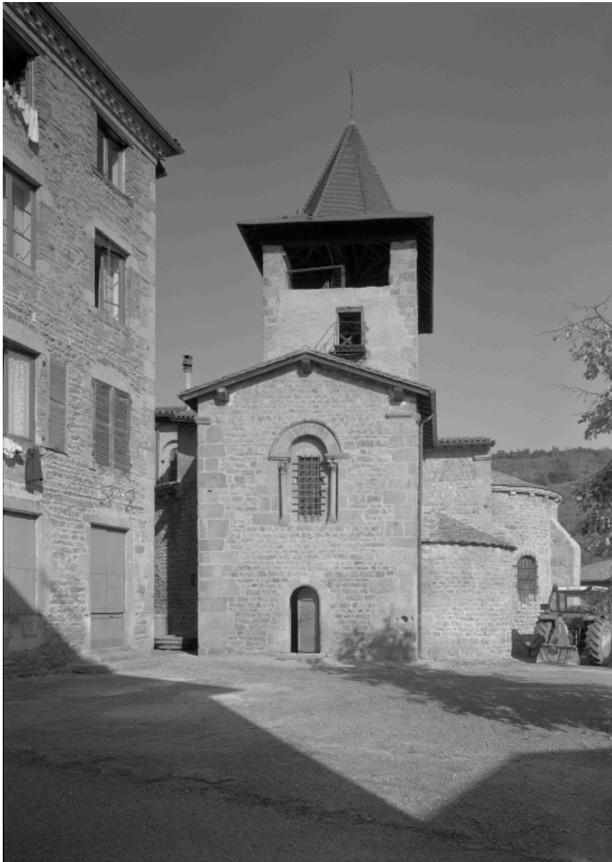
Vue du transept sud et du chevet, depuis le nord.
