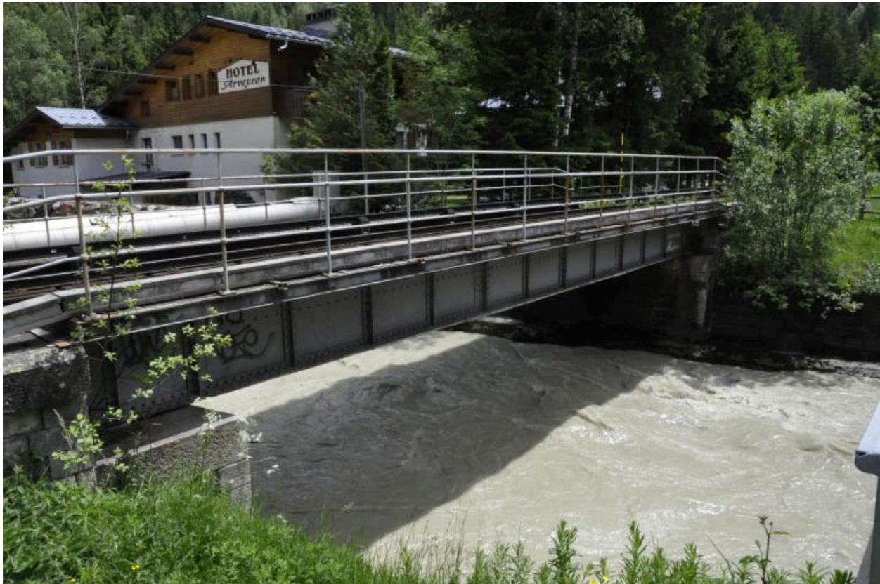
Vue du tablier métallique du pont enjambant le torrent de l'Arveyron prise depuis la rive gauche
