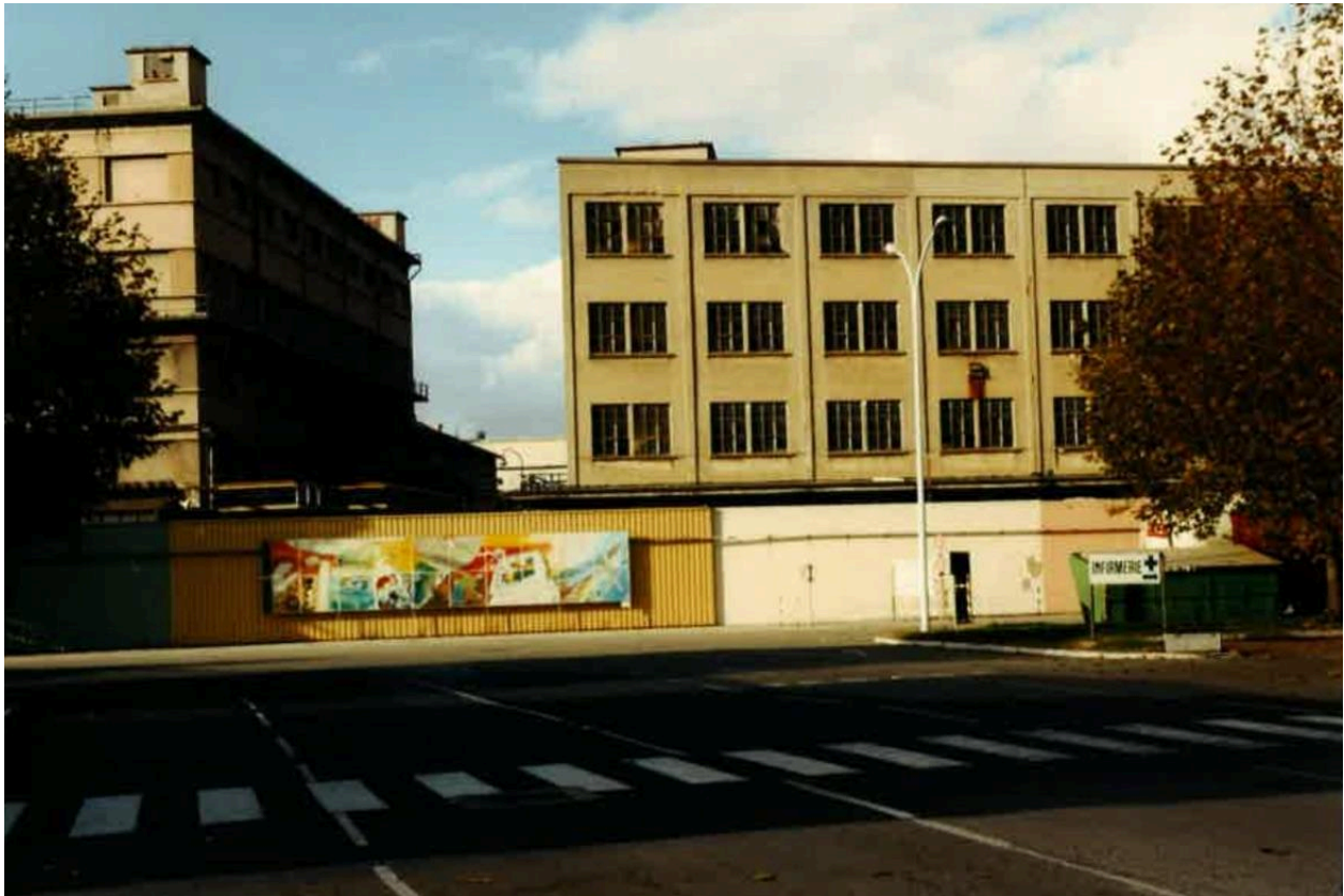
Usine Elf Atochem à Saint-Fons en 1996 (©Métropole de Lyon : 7152WM 509)
