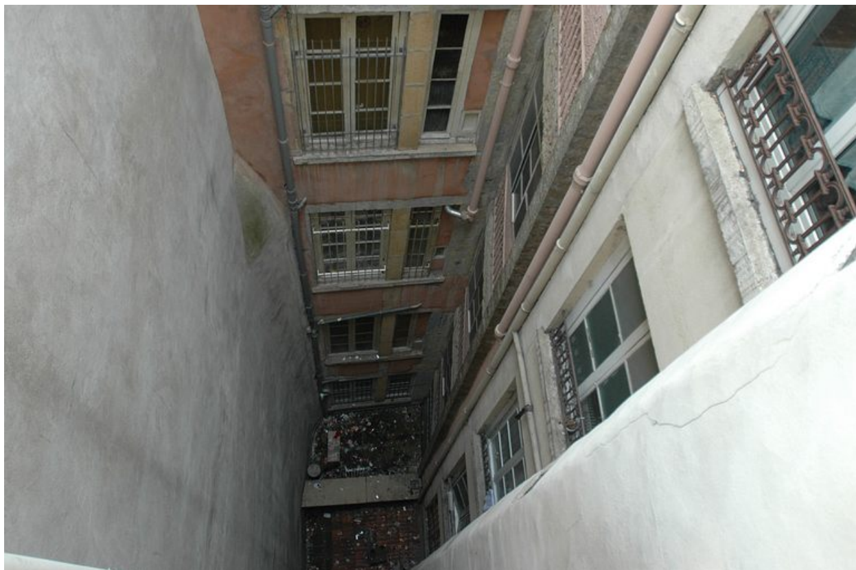
La courette, à l'ouest, en plongée
