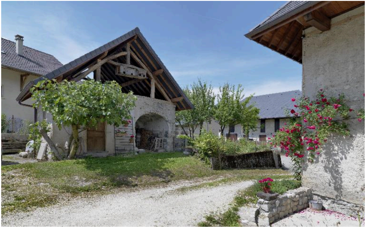
Vue d'ensemble de trois-quart avant gauche du four à pain.
