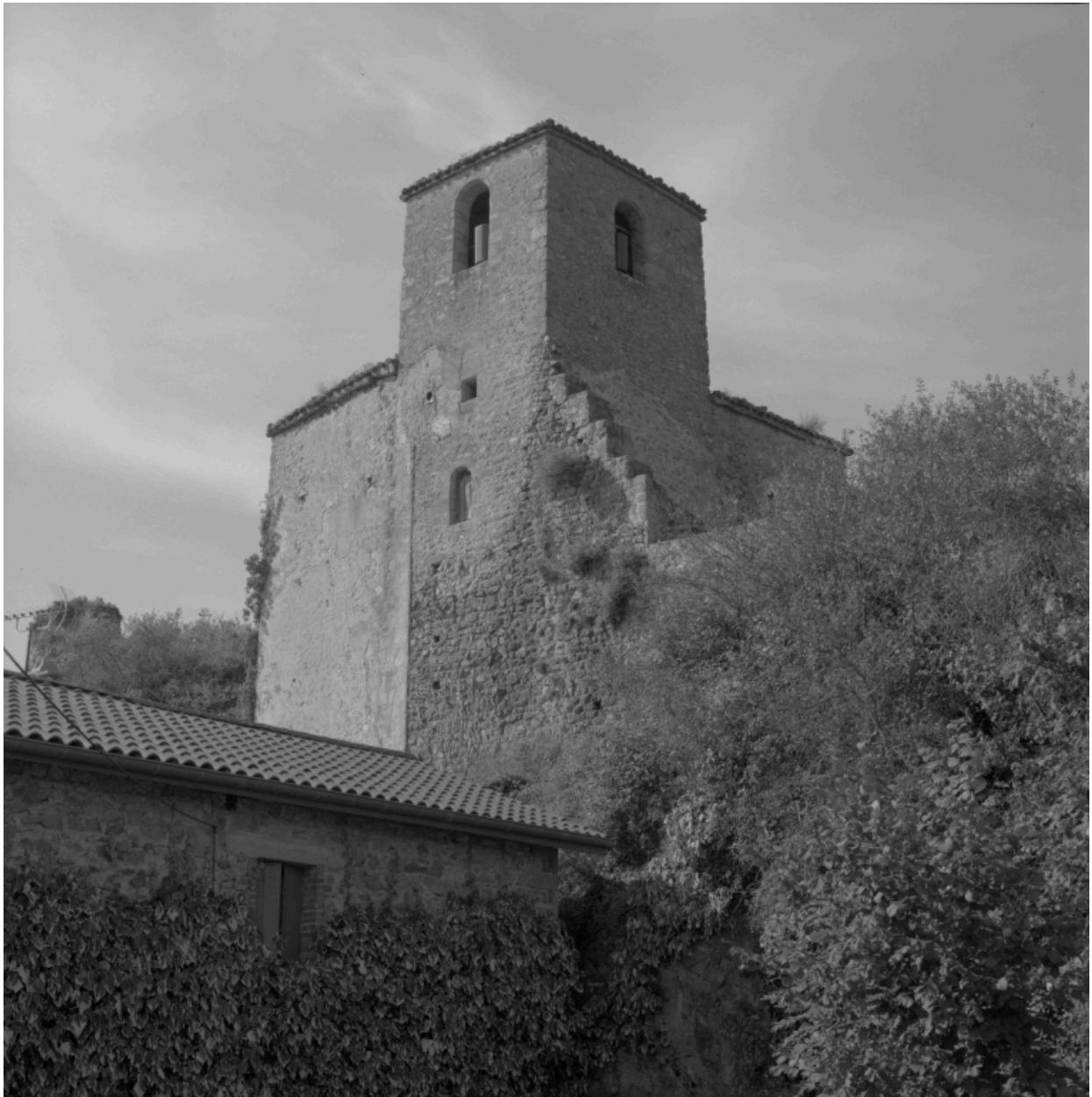
Vue d'ensemble de la face nord du chevet et du clocher, depuis le chemin d'accès en contrebas.
