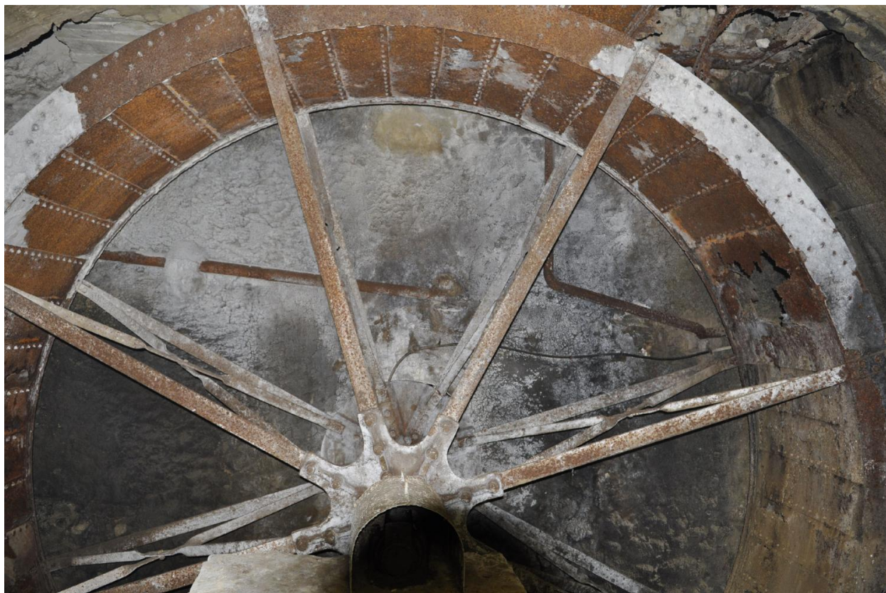
Roue de l'ancien système hydraulique (vue d'intérieur)
