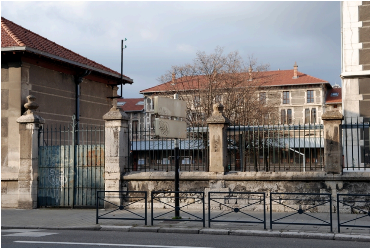
Le gymnase et la cour du gymnase, ancienne entrée sur la rue Lesdiguières, depuis le sud-est
