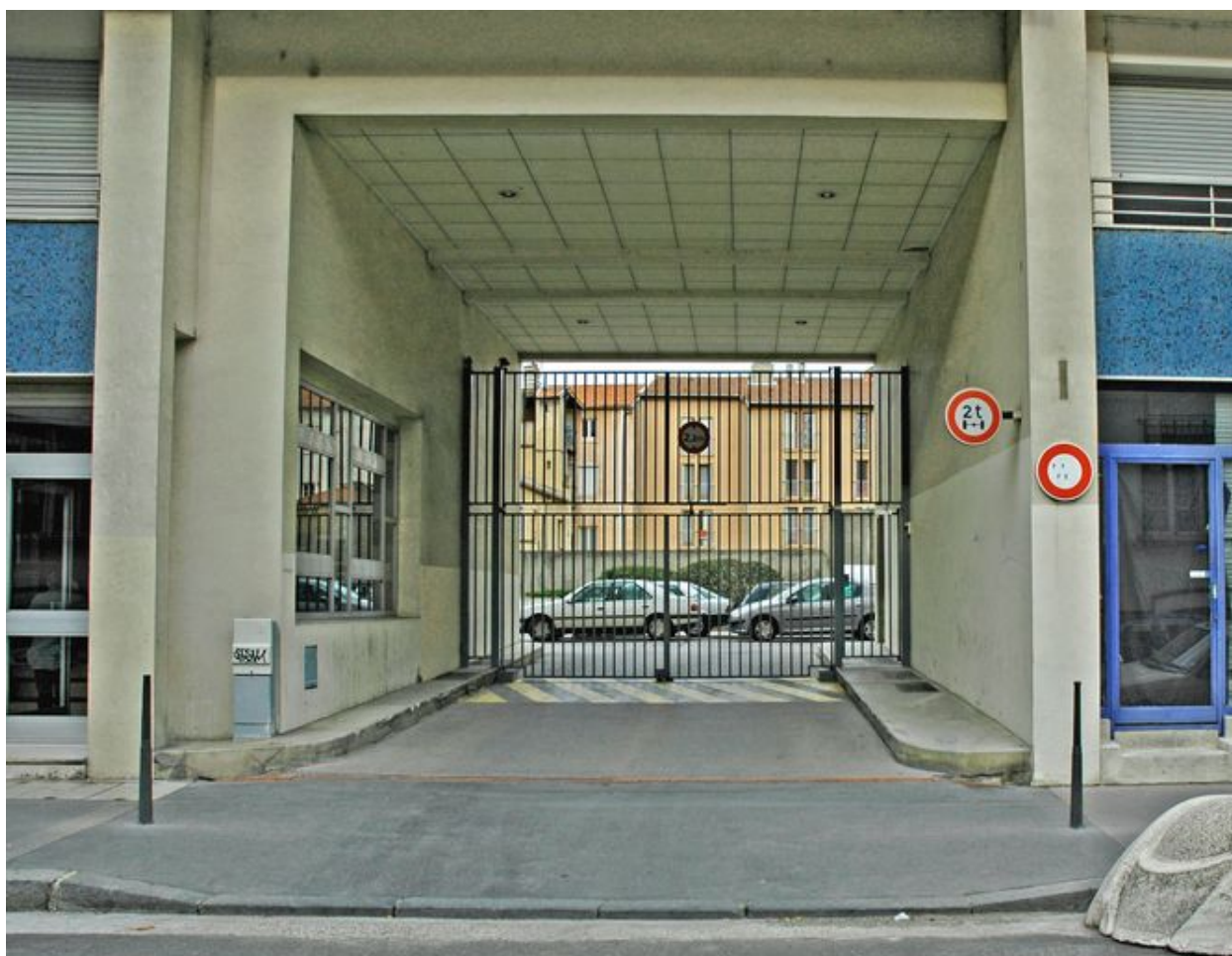
Passage couvert permettant l'accès au parking depuis la rue Rachais
