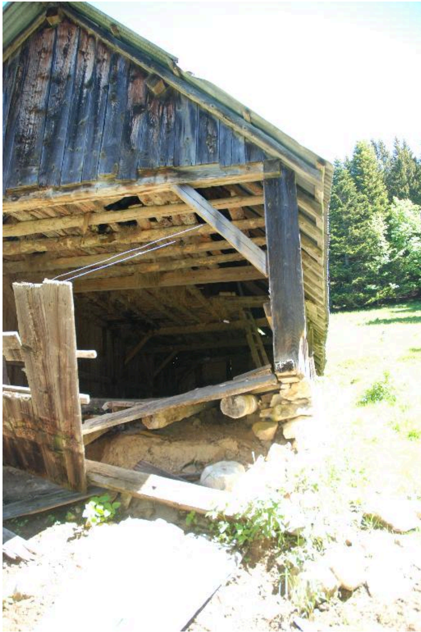
Vue du mur pignon sud de l'étable.
