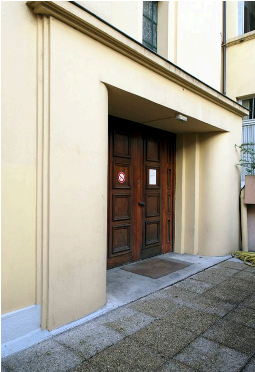
Cour intérieure, élévation latérale nord : porte menant au vestibule de la chapelle.
