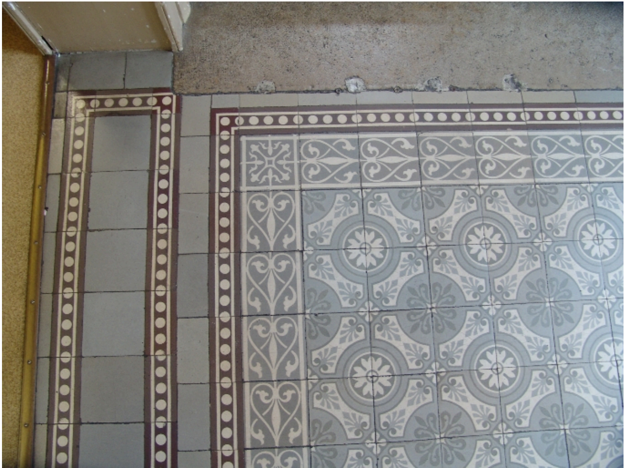
Carrelage du palier du 1er étage
