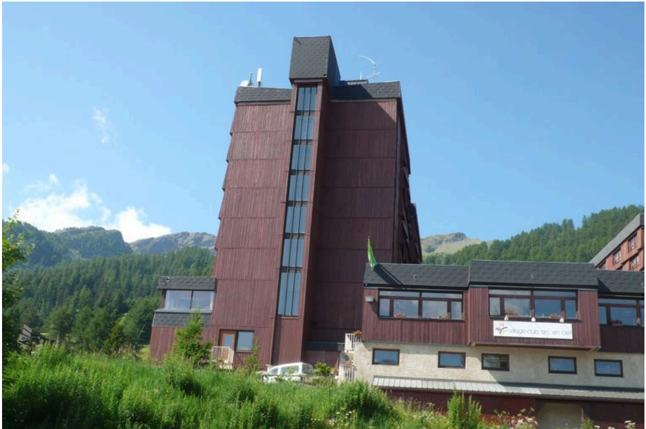
Pignon nord-ouest avec ascenseur panoramique
