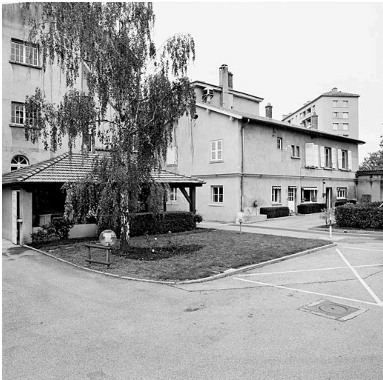
Vue nord des différents bâtiments
