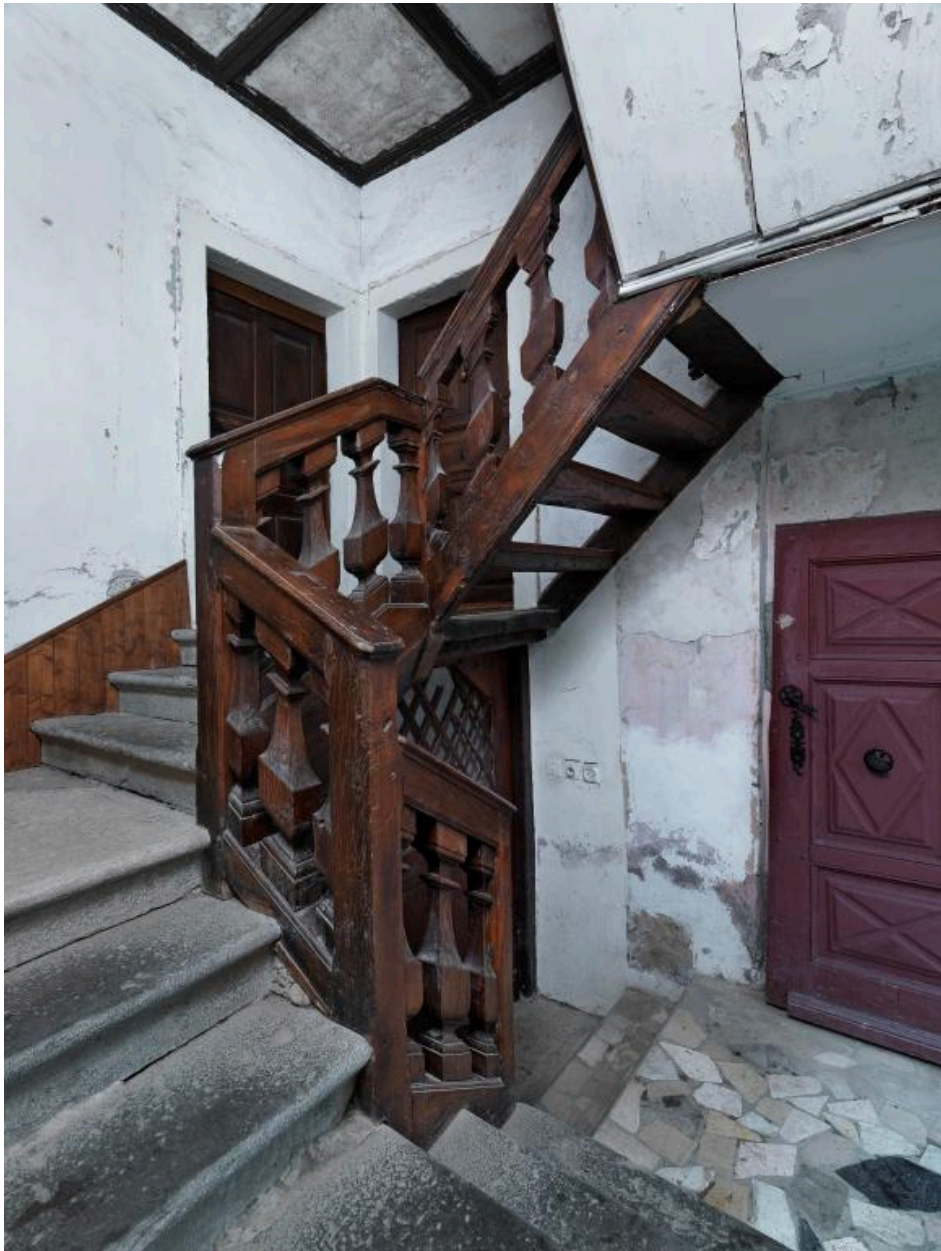
Vue intérieure : escalier.
