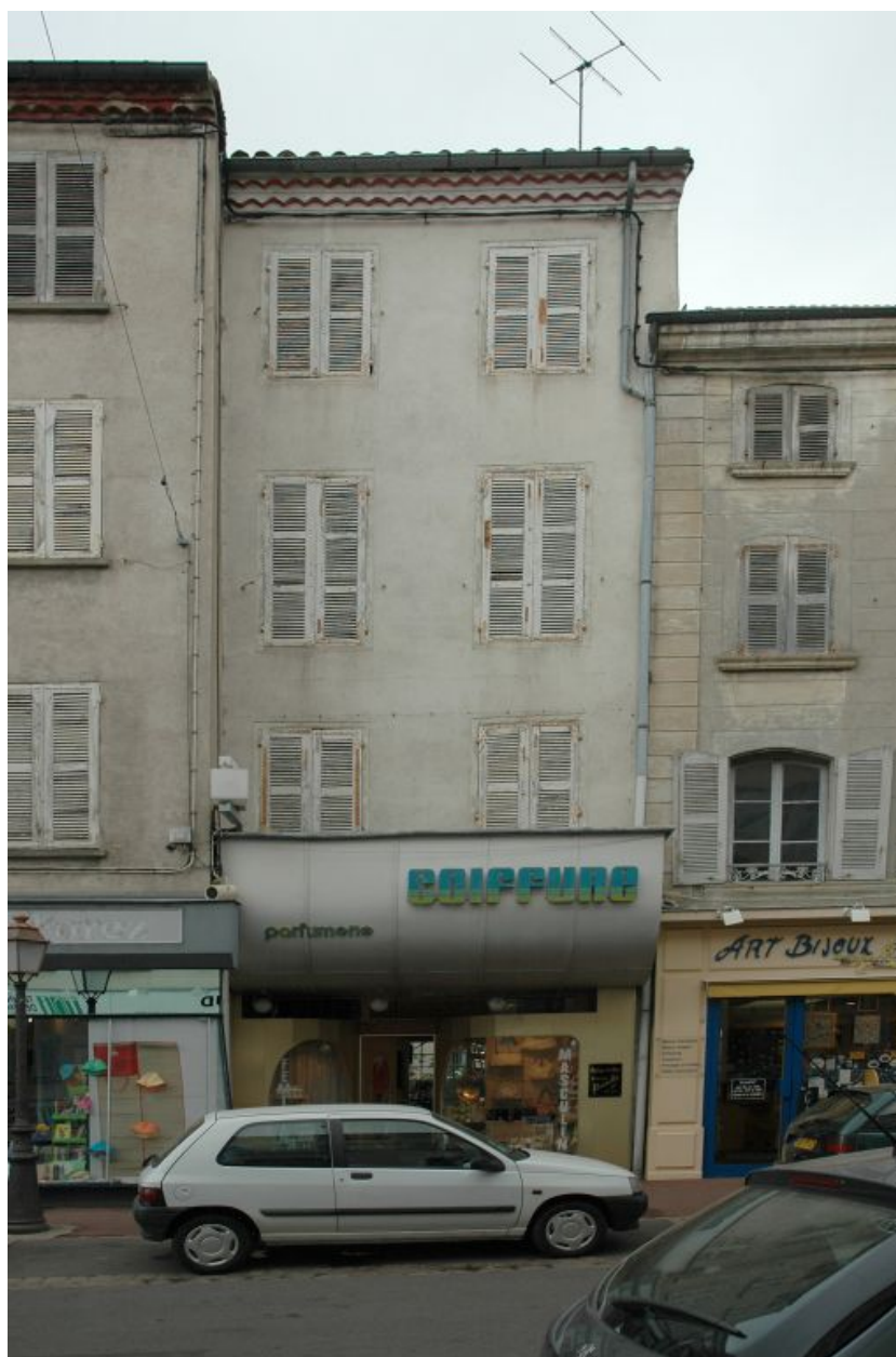
Vue générale depuis la rue Tupinerie.
