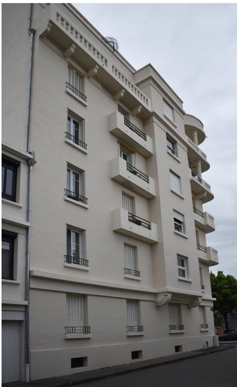
Elévation latérale, sur la rue Ledru
