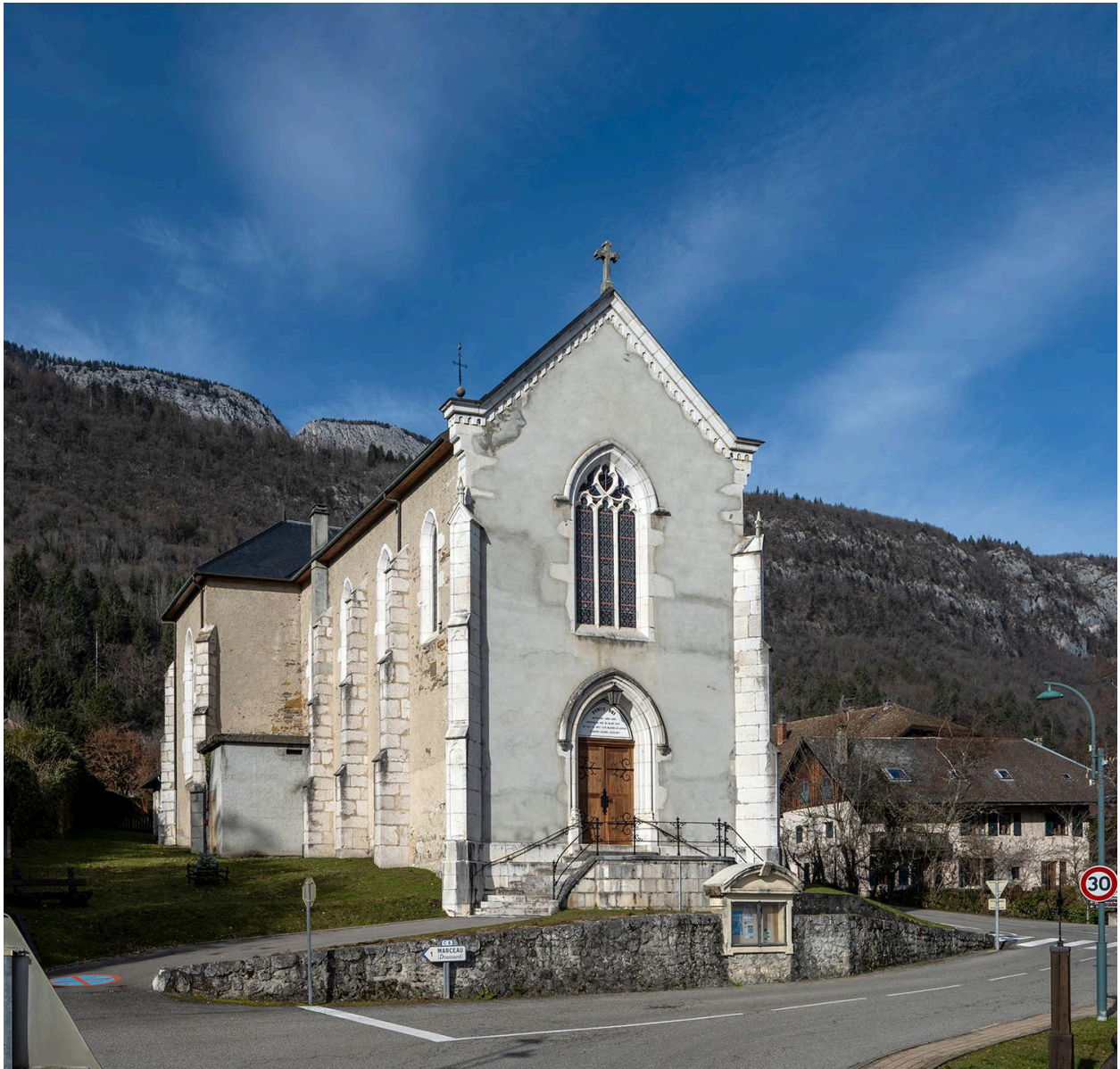
Vue de la façade.
