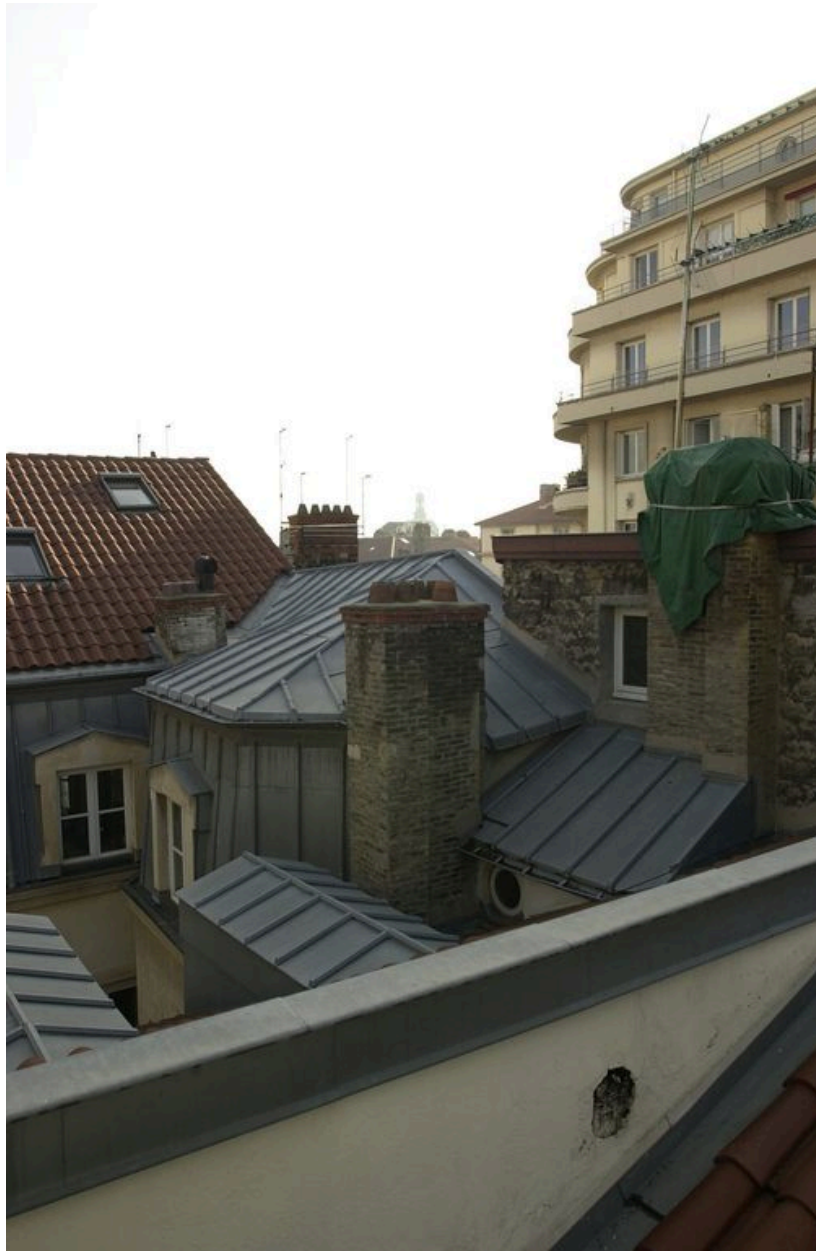
Etage de comble et toiture du corps de bâtiment sud sur cour depuis l'escalier du 10 rue de l'Ancienne-Préfecture
