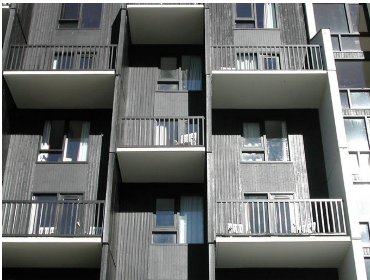
Détail des loggias
