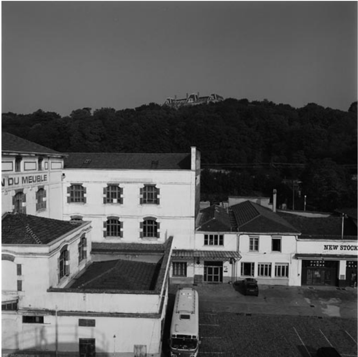
Bâtiment des semouleries, aile ouest
