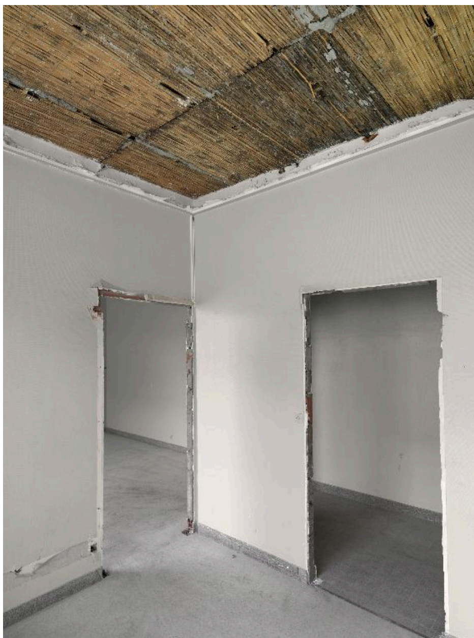
Le pavillon H en 2015 (en cours de déconstruction) : vue de situation d'un plafond avec "lattis" en roseau (au nord, côté cour anglaise au "sous-sol")
