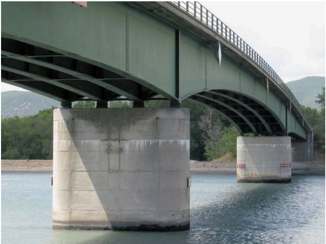
Tablier et piles, de côté, face amont, vue partielle (depuis la rive gauche)
