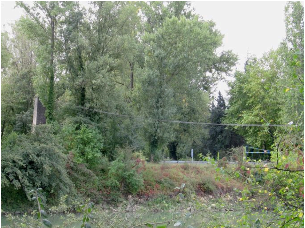
Vue générale, pile gauche et câbles (depuis la rive droite)
