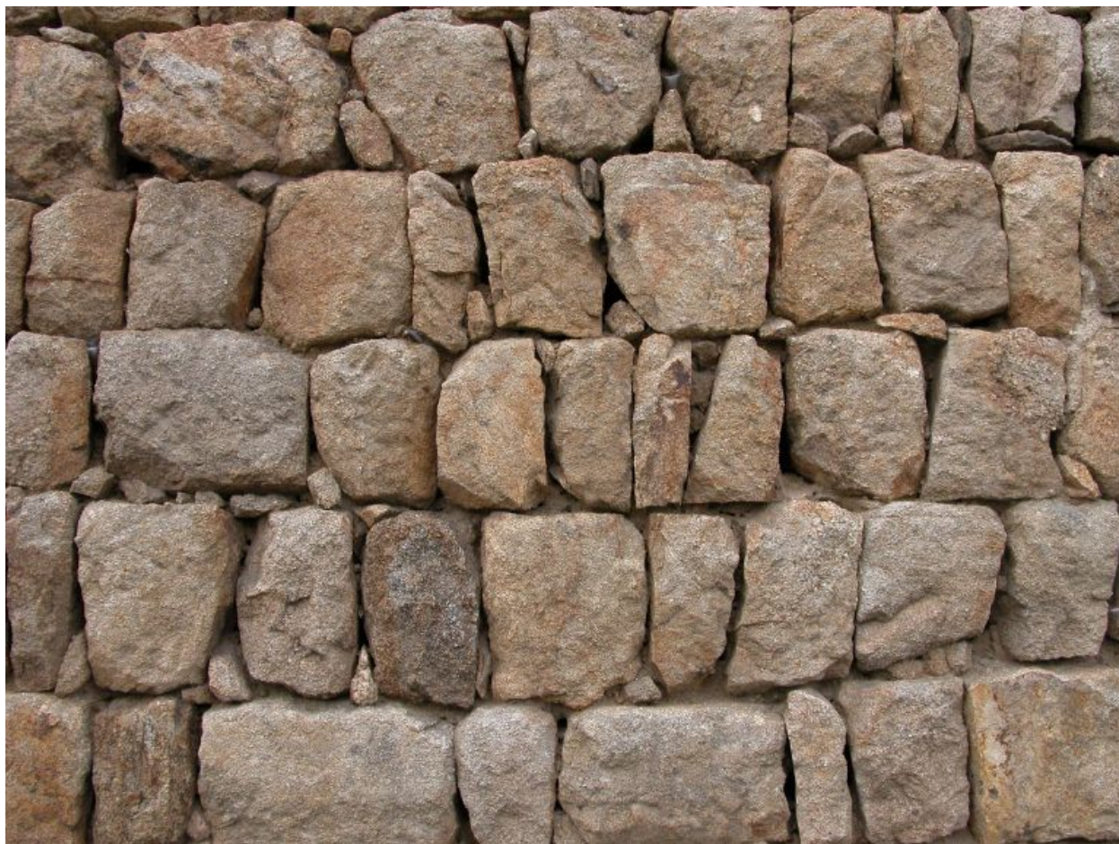
Etable est, détail des matériaux du mur pignon.
