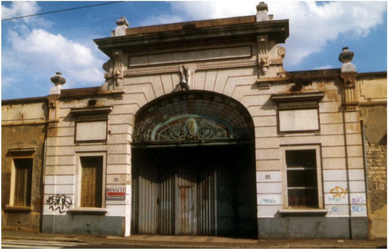
Entrée monumentale rue Feuillat
