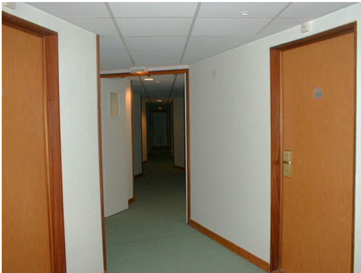
Coursive desservant les studios
