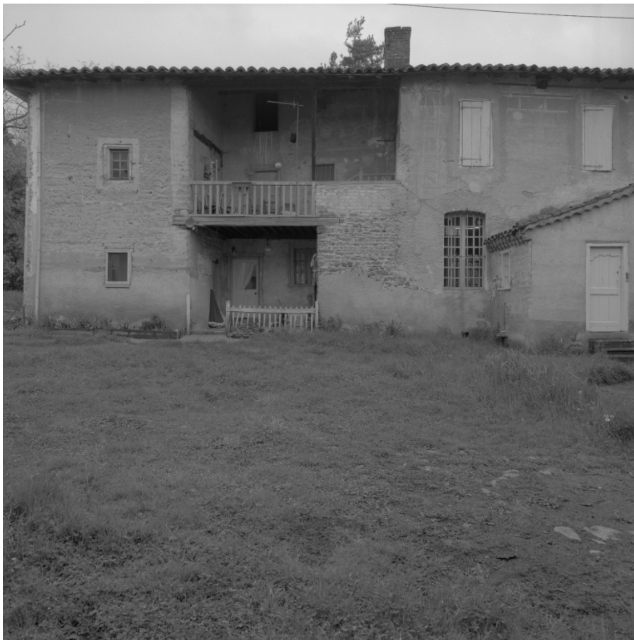
Vue d'ensemble du corps de logis du 16e siècle, façade antérieure.
