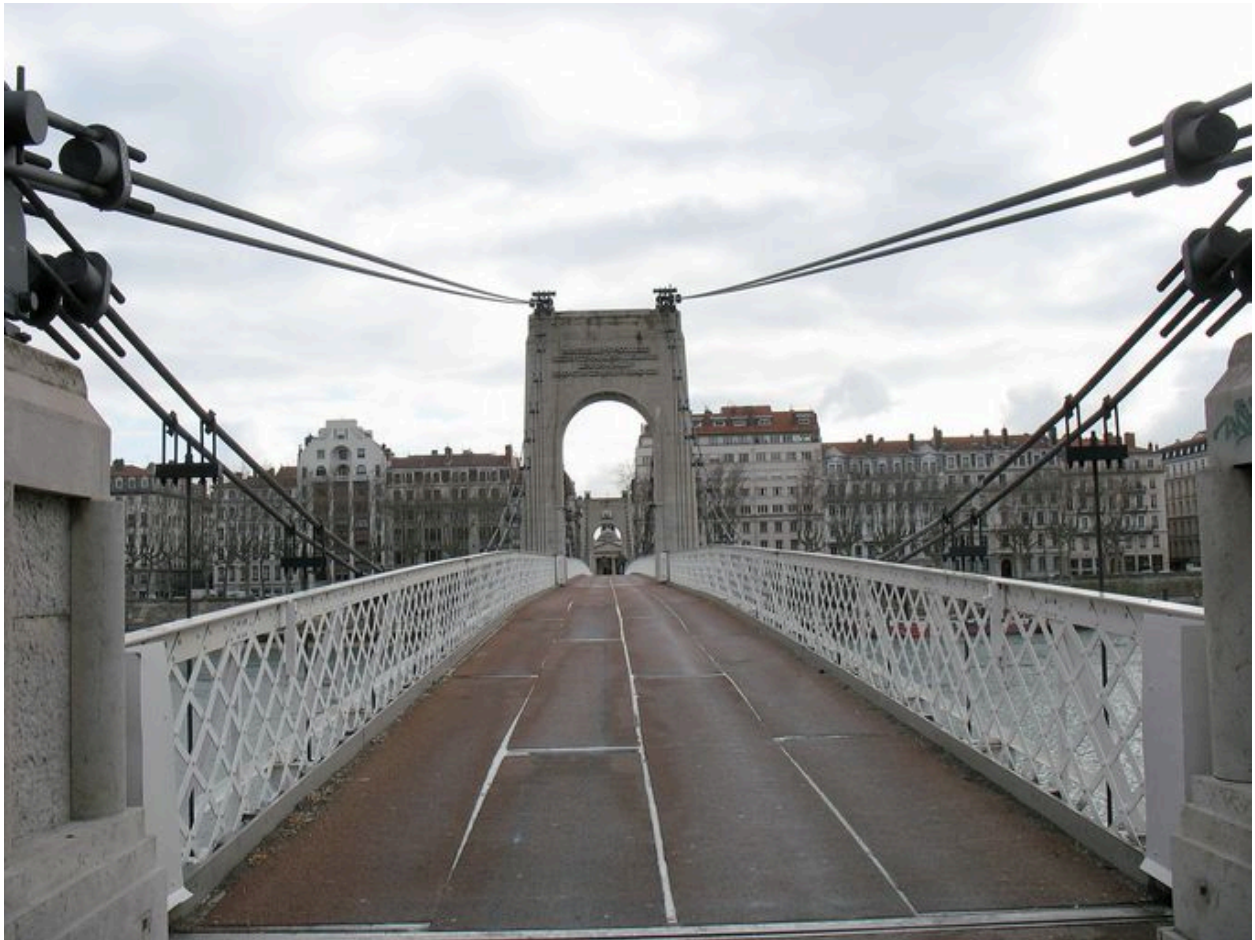
Sur le tablier, vue de la chaussée (depuis la rive droite)
