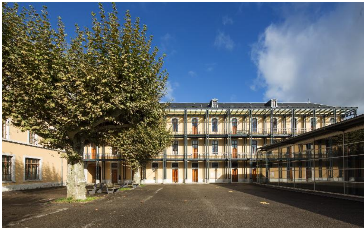
Cour 1 : vue sur façade du bâtiment 19e.
