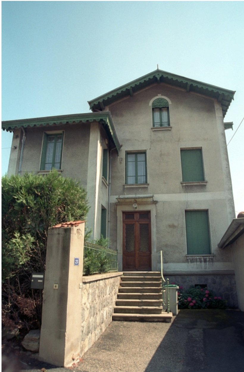
Boën, îlot 22, Alsace Lorraine (rue) 23. Vue générale de la façade sur rue.
