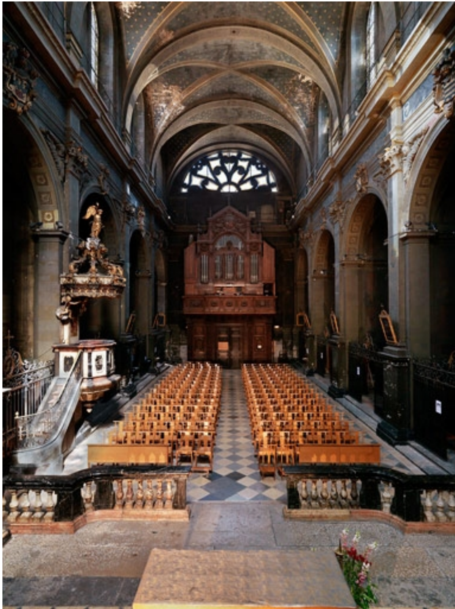
Intérieur : vue générale vers la nef
